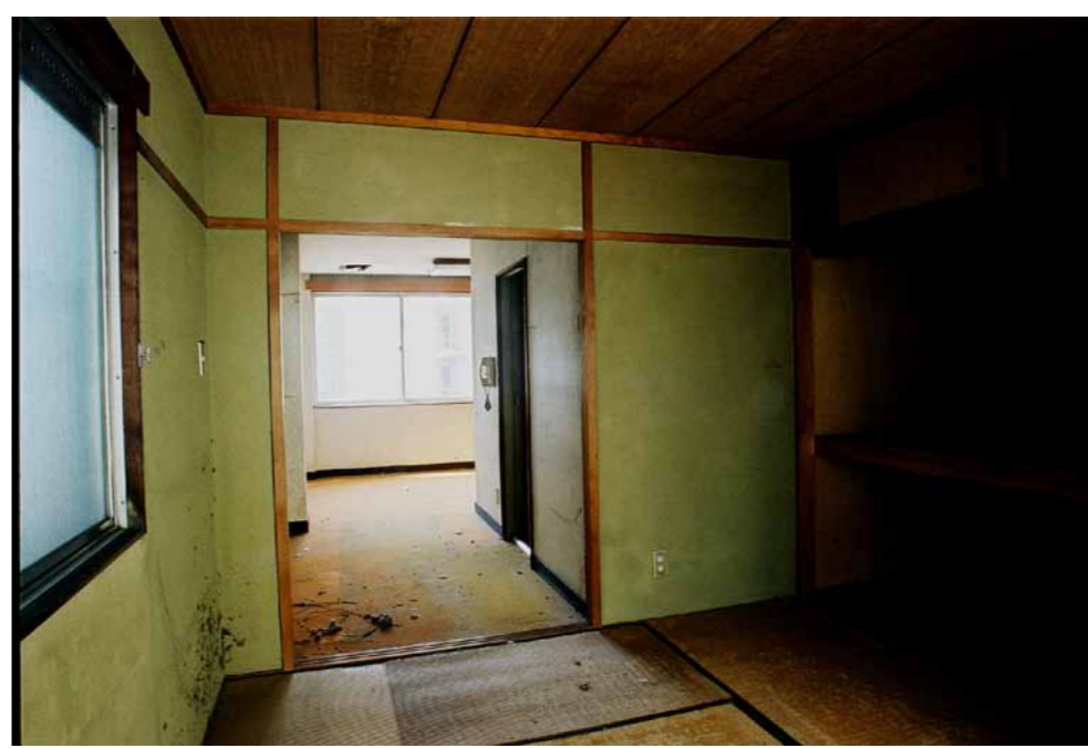
⑤ 4階和室から洋室を見る
